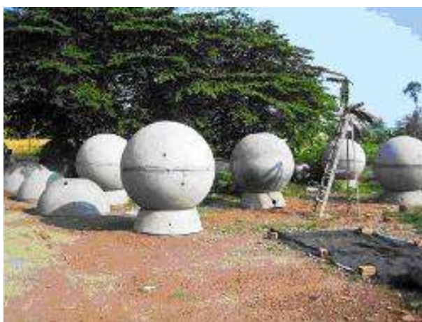
③建設中の Earth Tank
