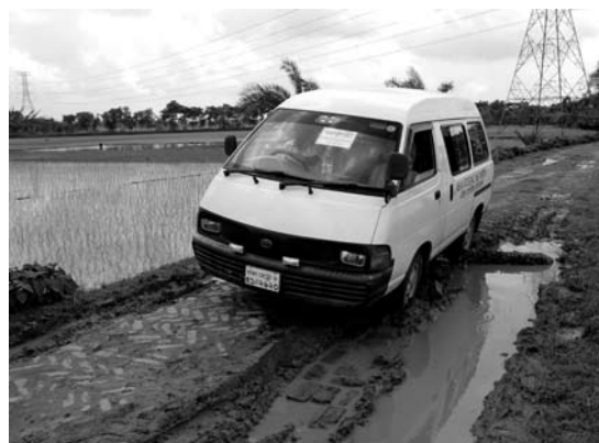
未舗装道路。雨季の度にあちこちの道が壊れるため、地方予算の大半が道の補修に回される
