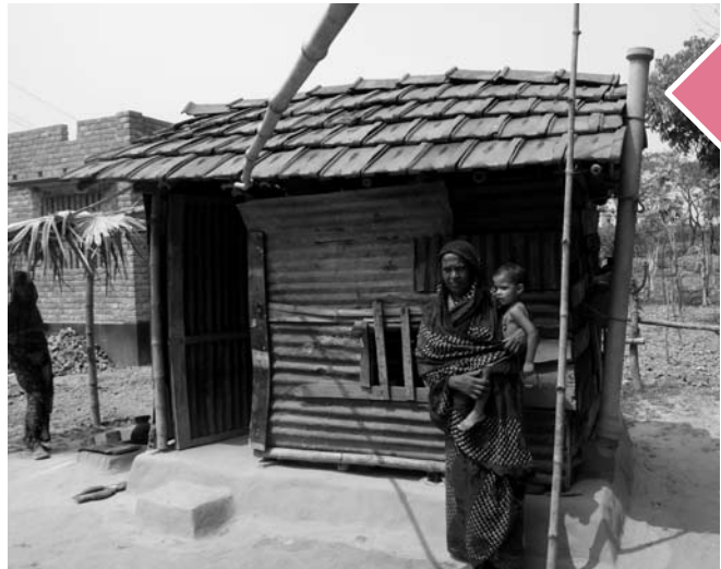
かまどに煙突をつけることで煙を吸い込むことがなくなり、 安全に調理ができるようになる
