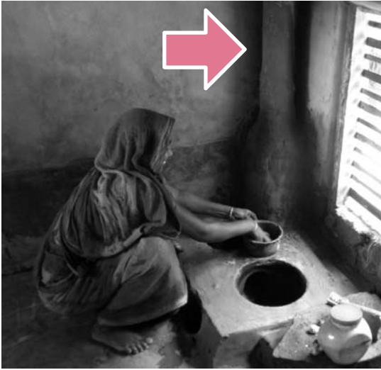
土と牛糞で、かまどを手作りする女性。 右奥に煙突が見える
