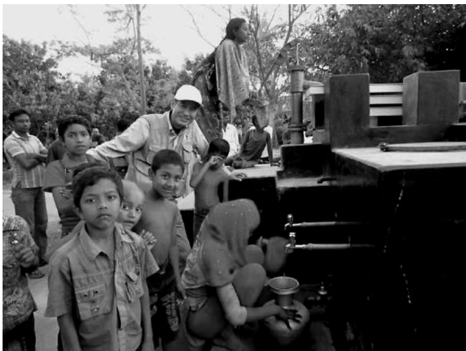
井戸に砒素を除去するフィルターを付けた共同水源。 地下水を上手に使いながら、次世代に安全な水をつないでいきたい。
